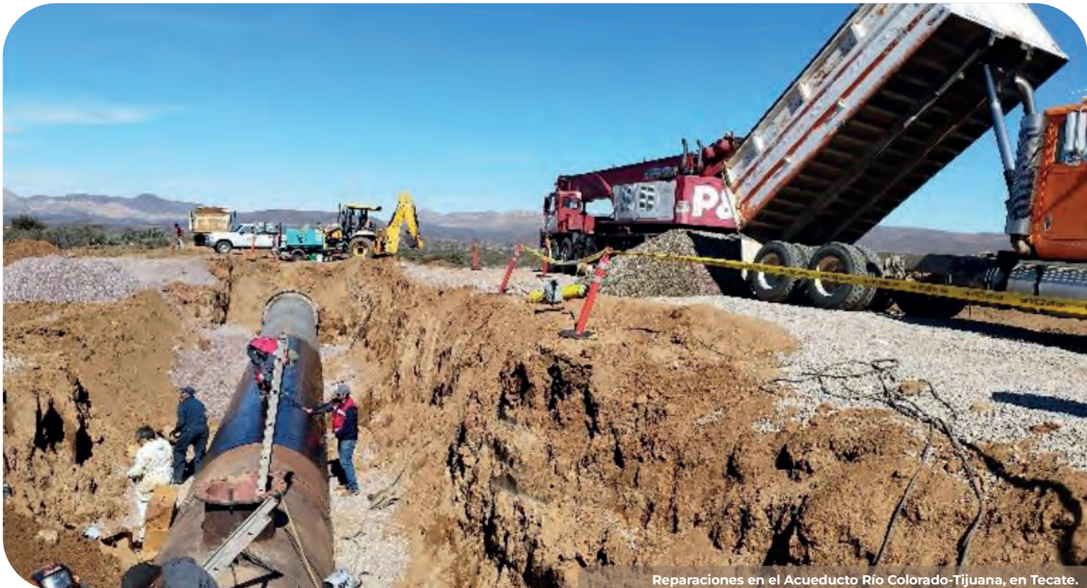
Reparaciones en el Acueducto Río Colorado-Tijuana, en Tecate.
