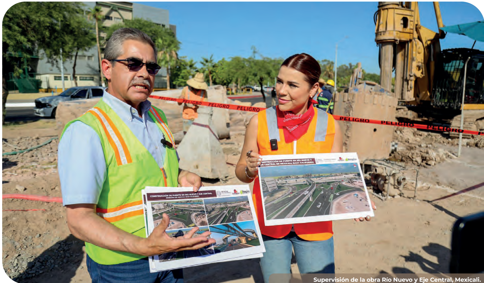
Supervisión de la obra Río Nuevo y Eje Central, Mexicali.
