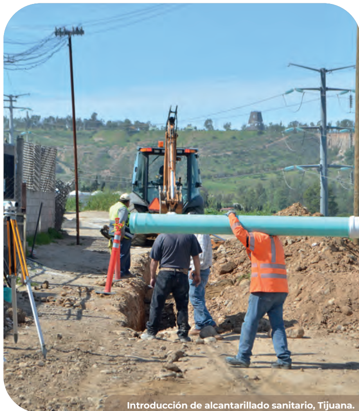
Introducción de alcantarillado sanitario, Tijuana.
