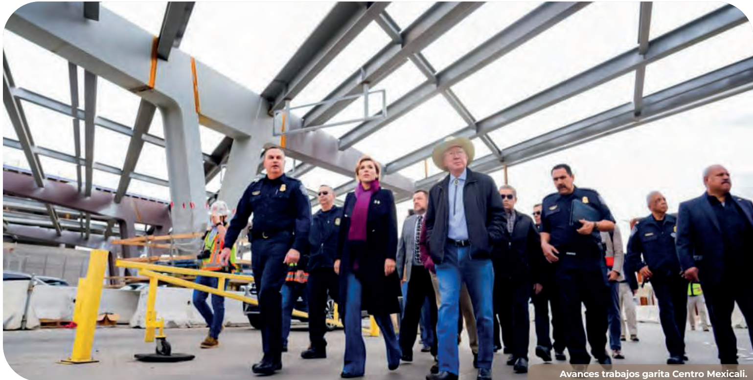
Avances trabajos garita Centro Mexicali.
