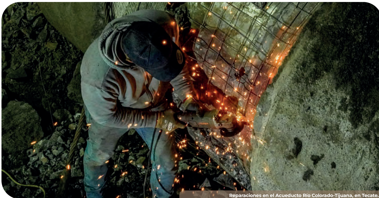
Reparaciones en el Acueducto Río Colorado-Tijuana, en Tecate.
