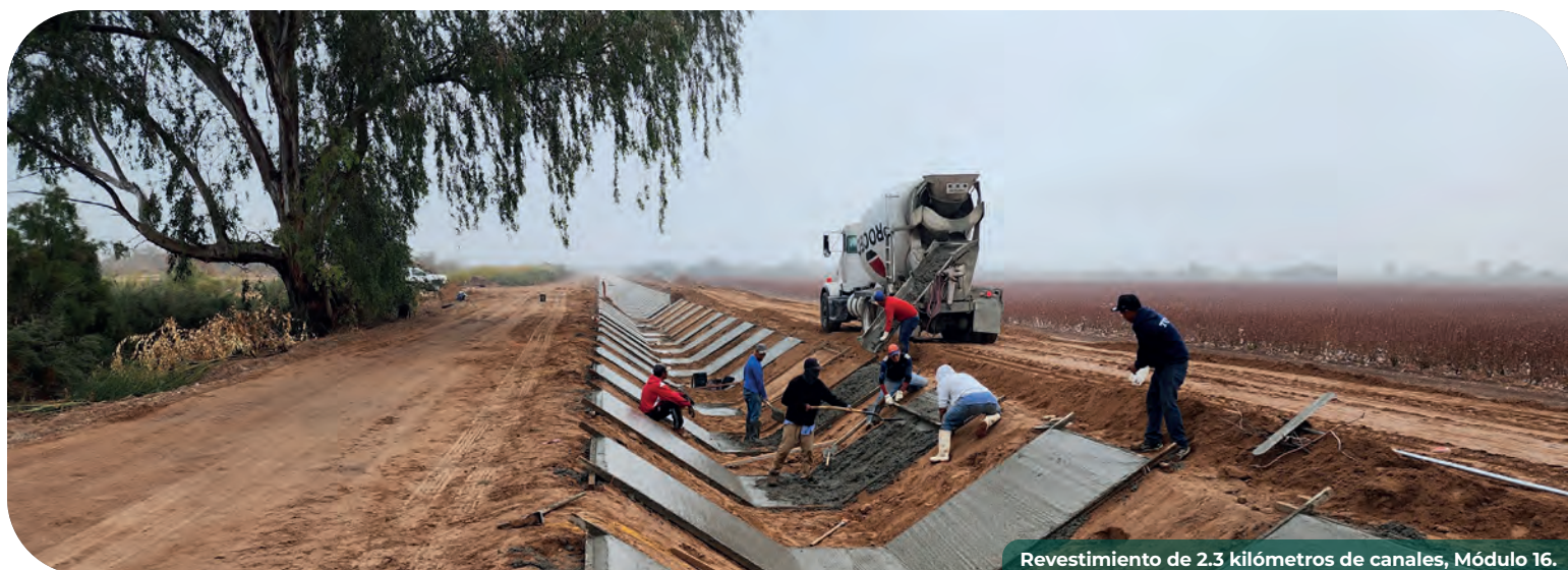
Revestimiento de 2.3 kilómetros de canales, Módulo 16.
