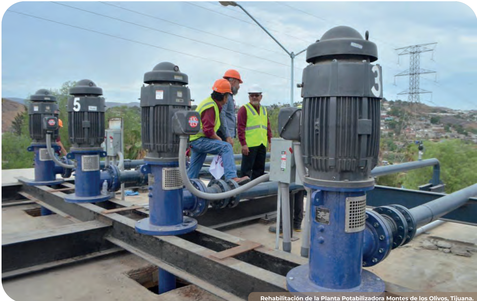
Rehabilitación de la Planta Potabilizadora Montes de los Olivos, Tijuana.
