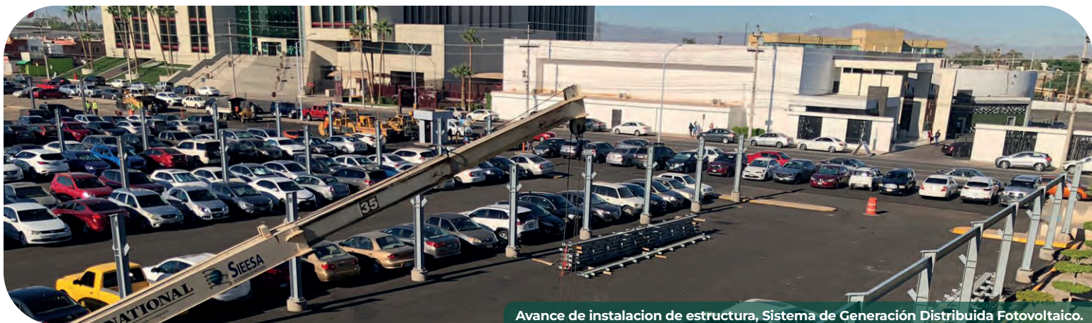
Avance de instalación de estructura, Sistema de Generación Distribuida Fotovoltaico.
