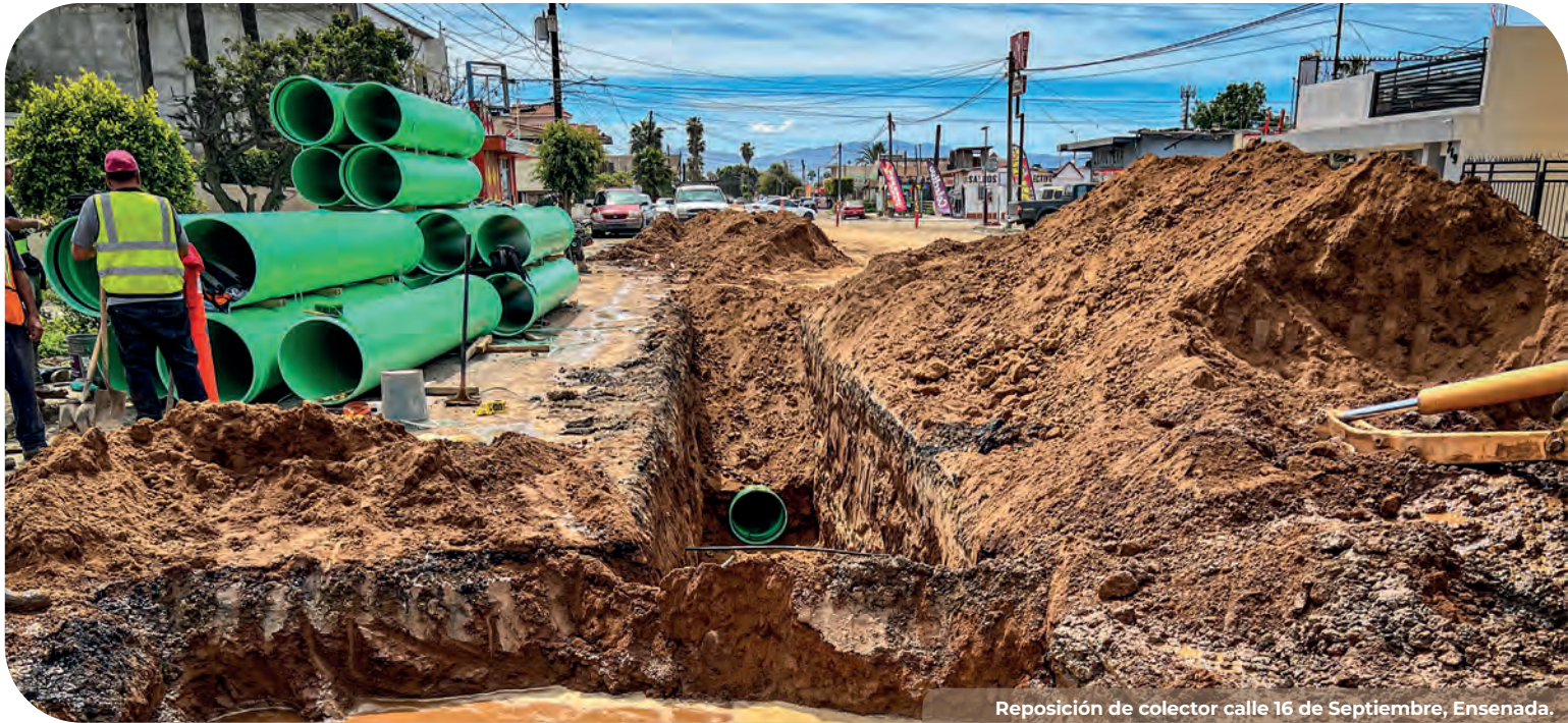
Reposición de colector calle 16 de Septiembre, Ensenada.
