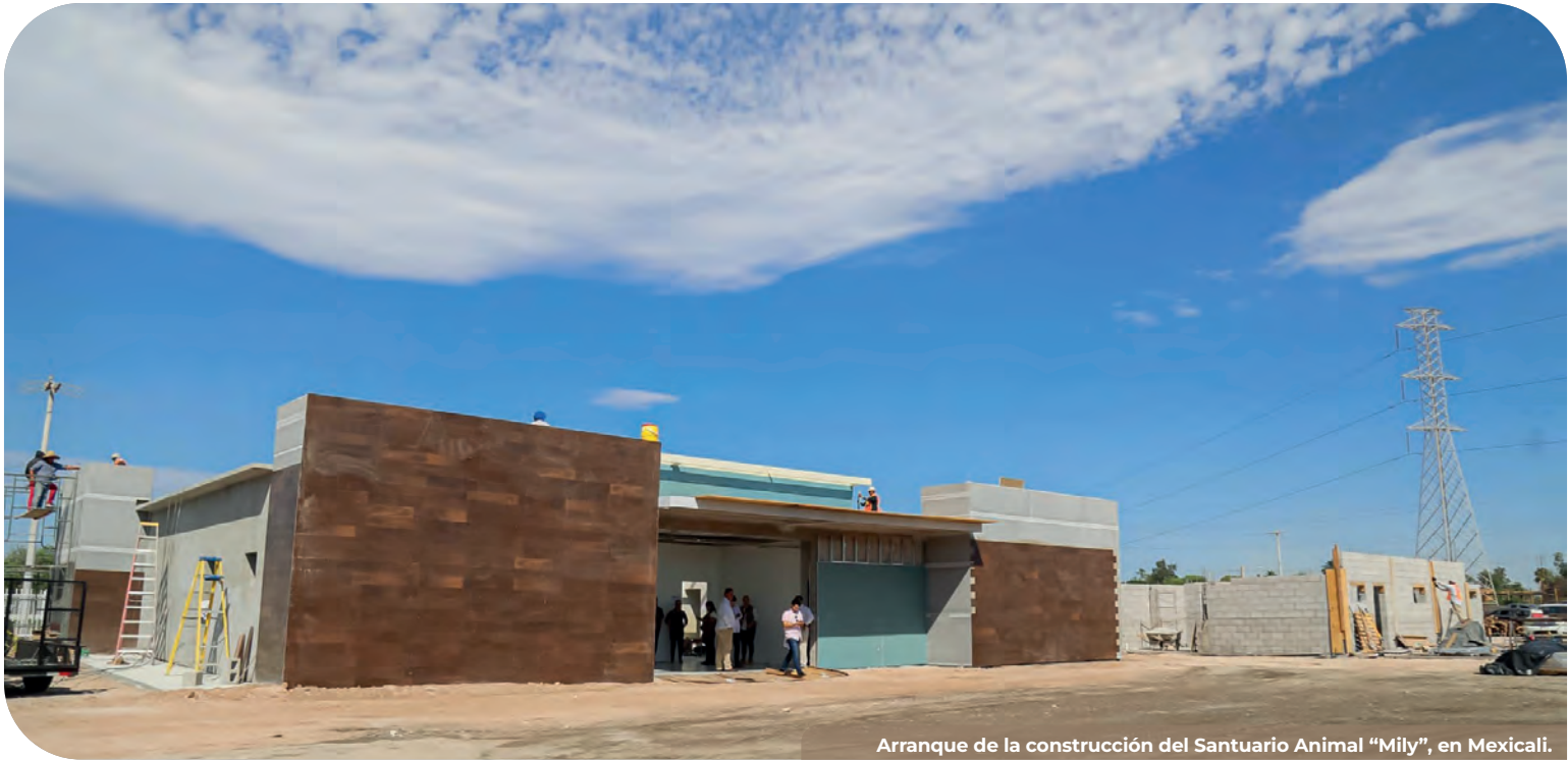
Arranque de la construcción del Santuario Animal "Mily", en Mexicali.
