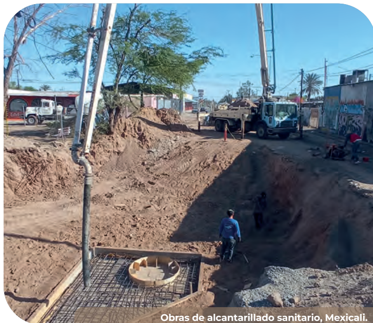
Obras de alcantarillado sanitario, Mexicali.
