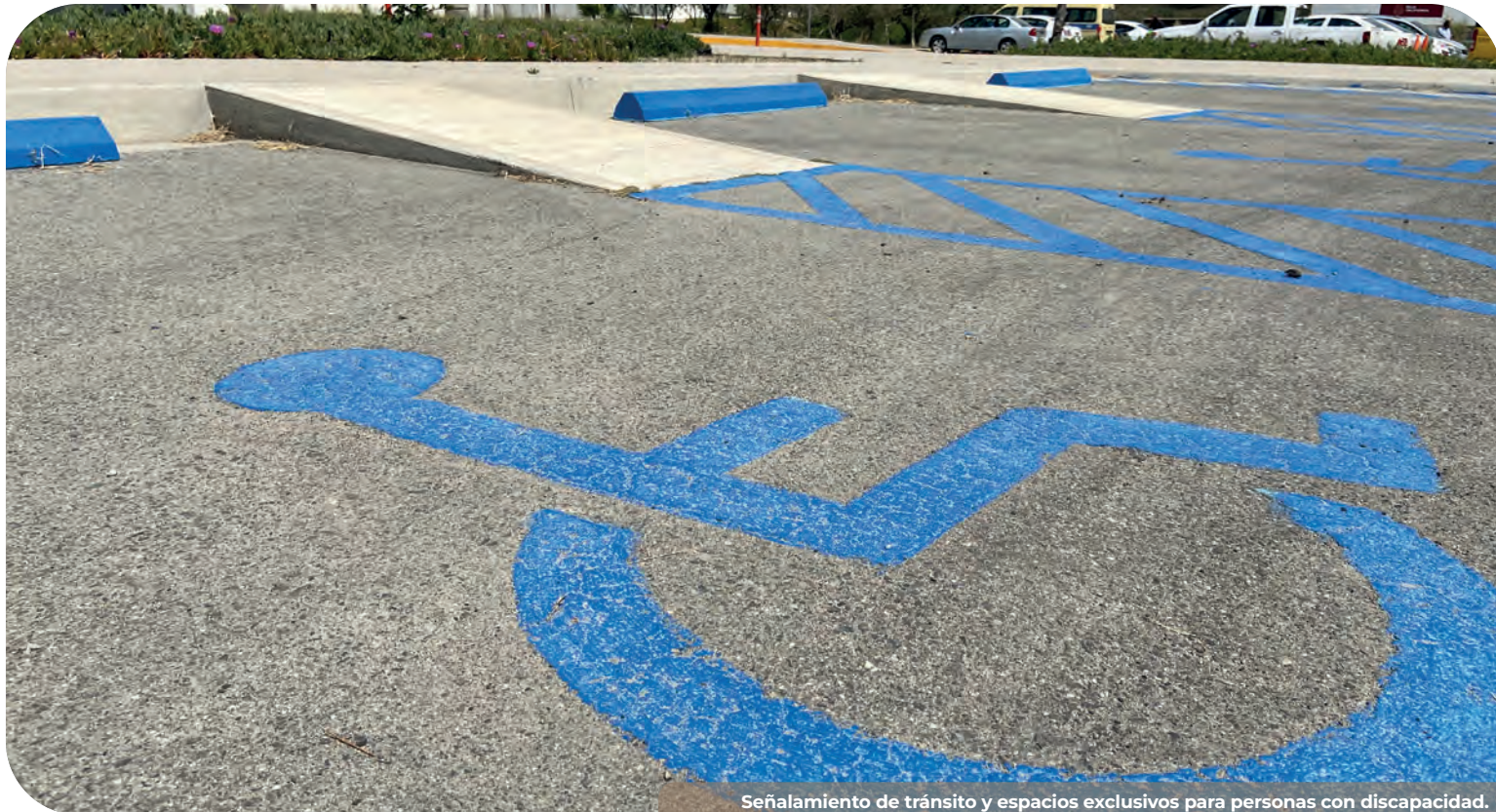
Señalamiento de tránsito y espacios exclusivos para personas con discapacidad.
