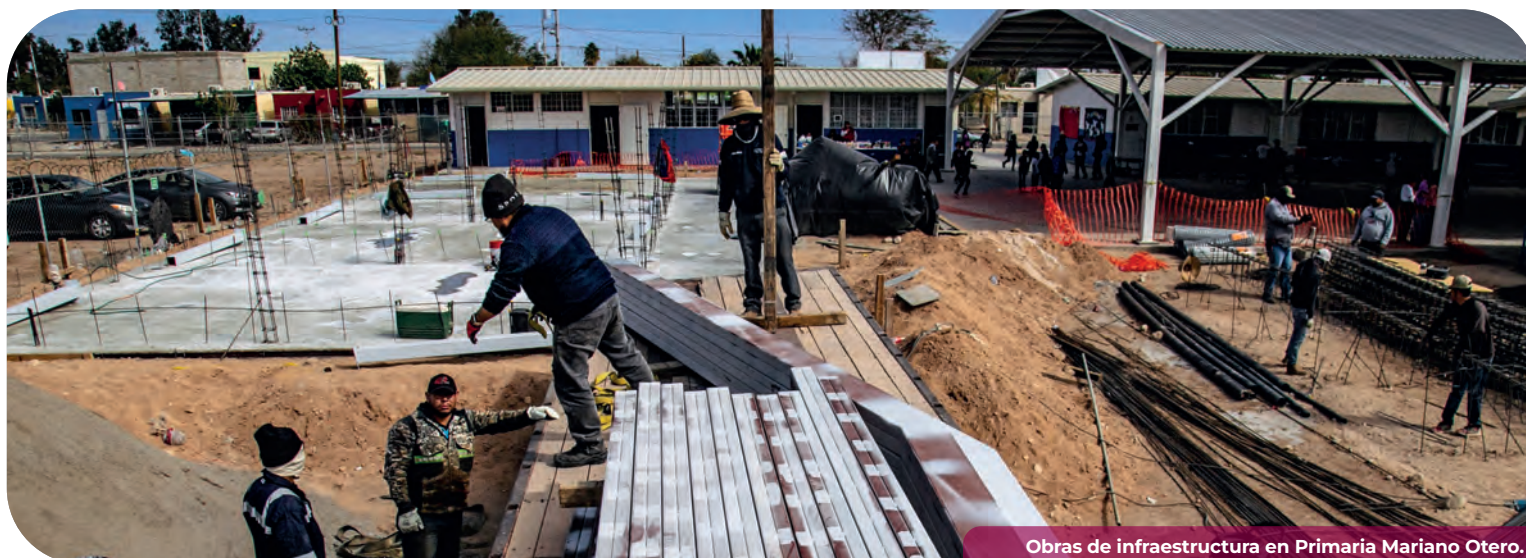
Obras de infraestructura en Primaria Mariano Otero.
